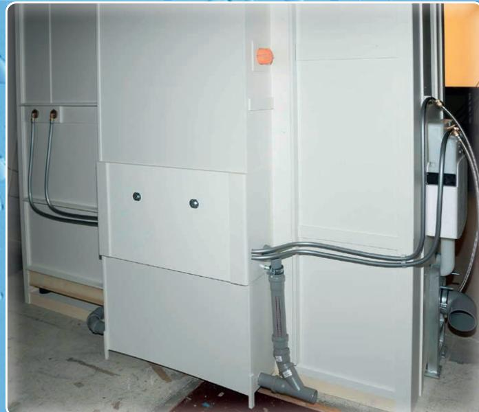
Alle Elemente rund um die Duschwanne werden in den Anschlussfugen vor dem Zusammenstecken mit Silikon ausgespritzt. Diese Silikondichtungen bleiben verdeckt und sind nach dem Aufbau nicht mehr sichtbar.
